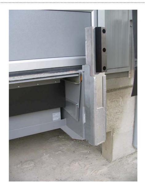
Höhenbeweglicher Anfahrpuffer zum Andocken von Fahrzeugen mit erhöhter Ladekante zum Schutz gegen ein Überfahren der Rampenkante. Sicheres Andocken, Möglichkeit zum Öffnen der LKW – Türen nach dem Andocken durch manuelle Absenkung der Puffer bis auf Rampenebene und selbsttätige Rückkehr in die Arbeits- bzw. Ausgangsposition. Leichte Bedienbarkeit über Gasdruckfedersystem.
