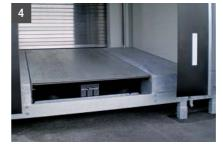
Nach Beendigung der Verladung wird die Überladebrücke per Autotaster in die Ruheposition gefahren. Die LKW-Türen werden geschlossen und die Torabdichtung entlüftet. Der LKW kann die Ladestelle wieder verlassen.
