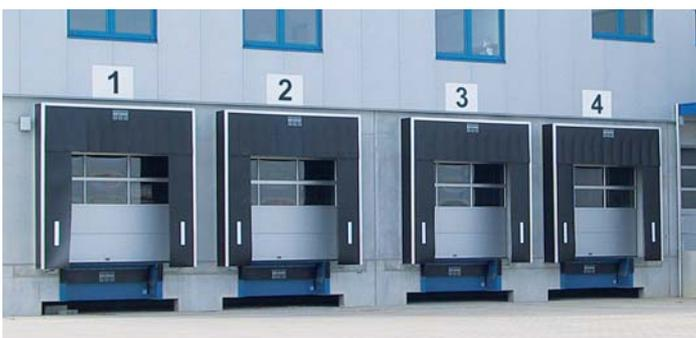
Nummerierung von Ladestellen und Toranlagen aus Aluminium oder Siebdruck auf Kopfplane.
