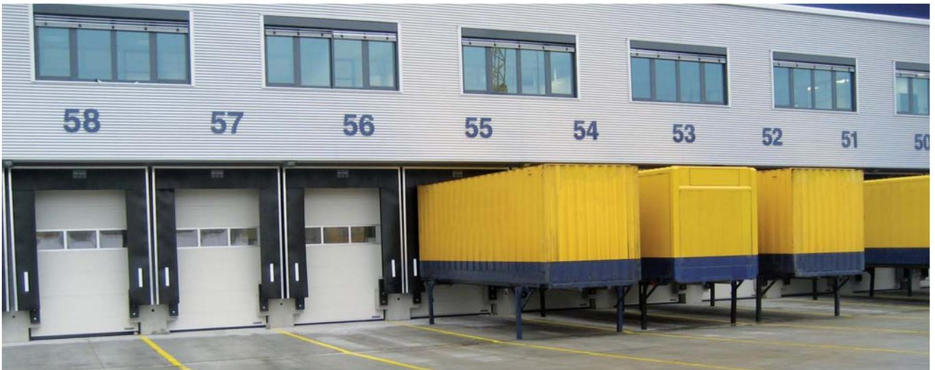
Planentorabdichtungen, auch ohne Federsystem, zum Einbau in einen bauseitigen Beton- oder Stahlrahmen.
